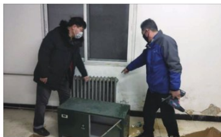
蒋胜利在校本部医学观察区的建设现场
