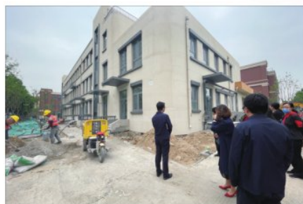
相关负责人到首经贸附属幼儿园项目工地实地勘察
